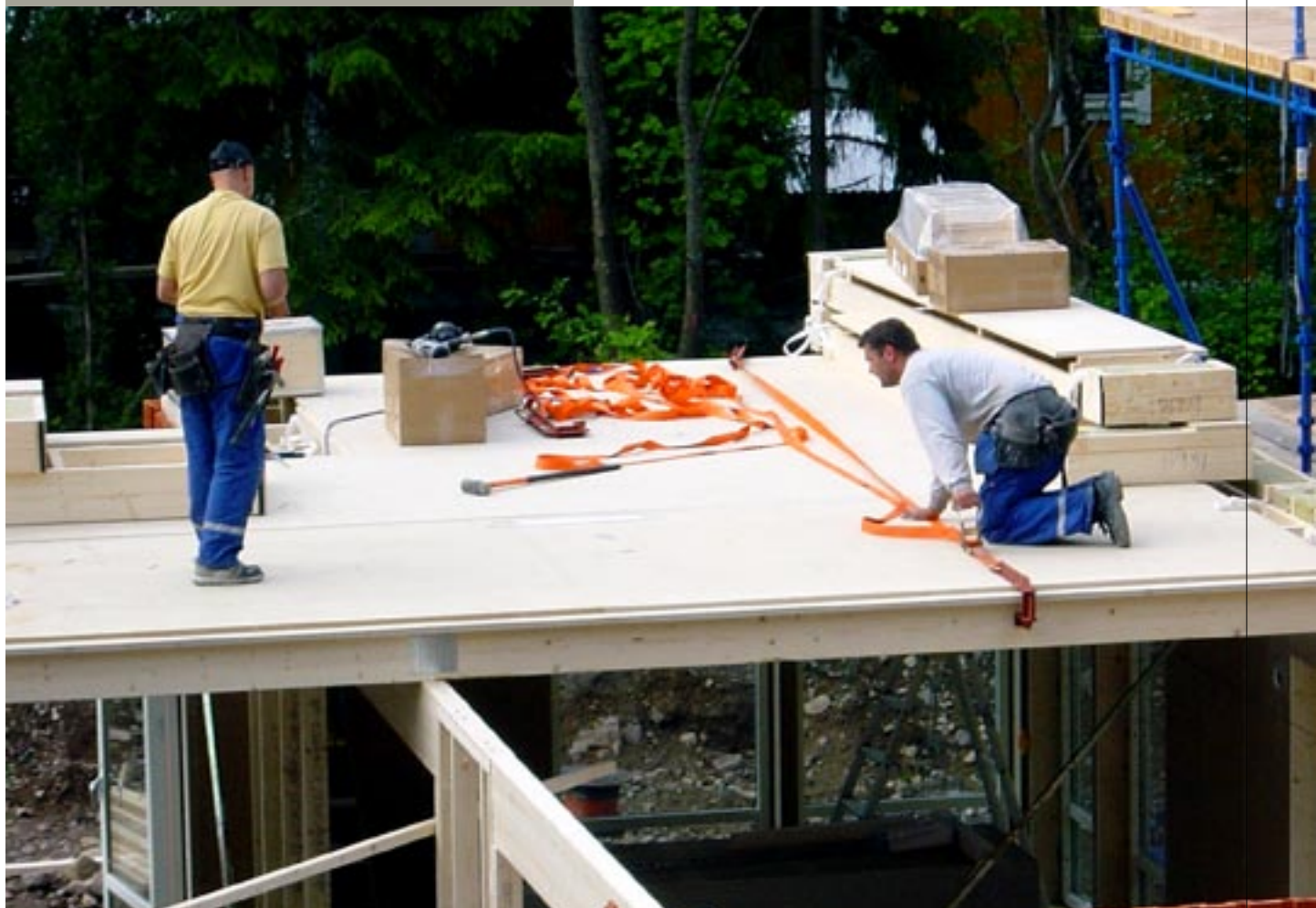
Montage av bjälklaget i huset med 12 % fuktkvot i det produktutvecklade konstruktionsvirket.
