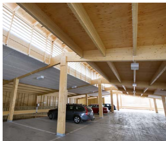
Parkeringshus med stomme av limträ och korslimmat trä, KL-trä, Ekorren, Skellefteå.
