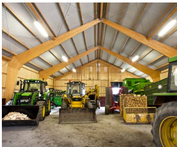
Maskinhall av treledsramar med fingerskarvade ramhörn, Söderköping.
