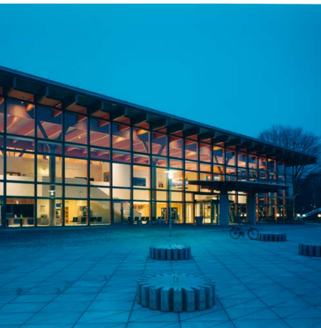
Stifts- och landsbiblioteket i Linköping. Takbalkar av limträ på pelare av betong.
