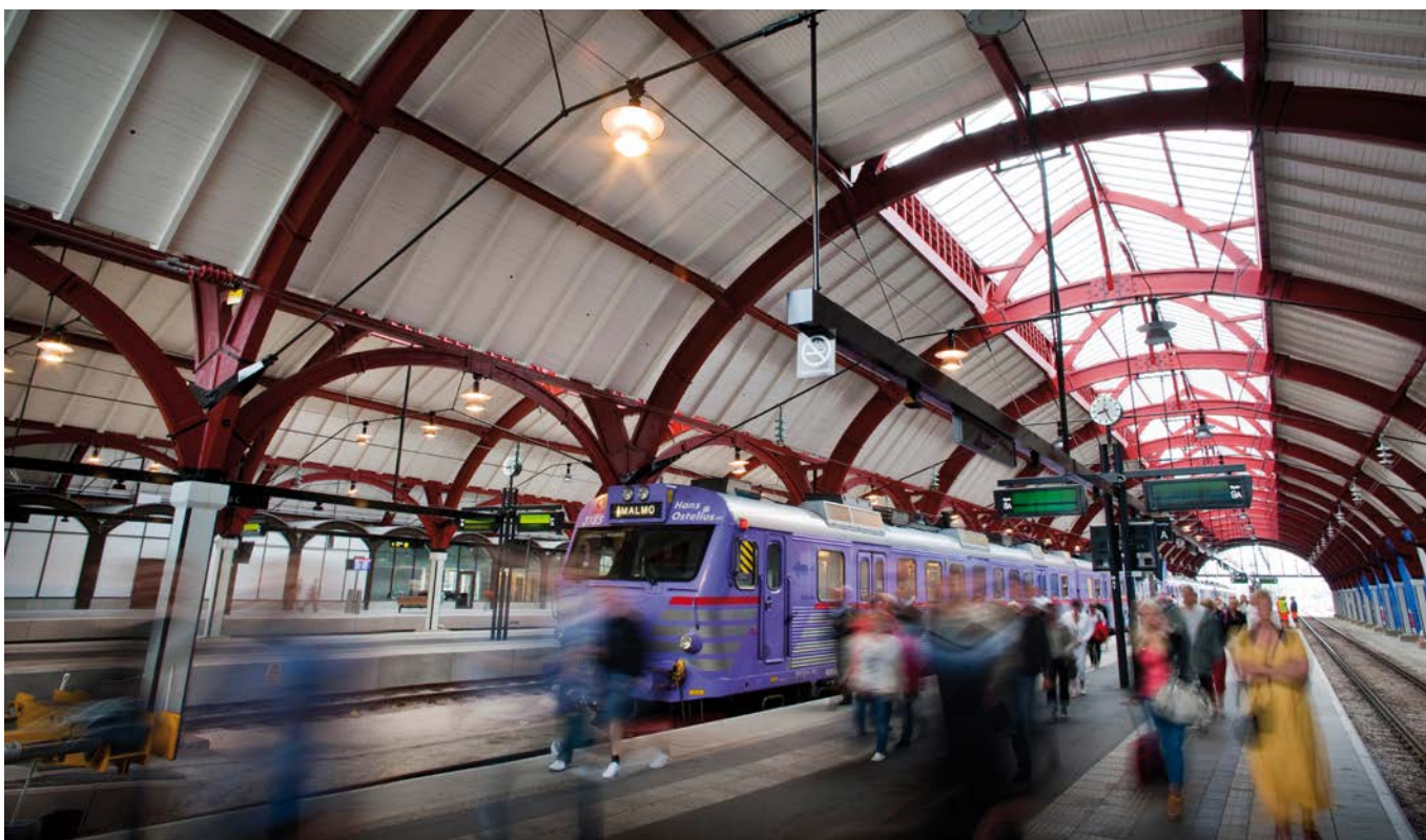
Malmö Centralstation. Banhall byggd 1923. En av de första stora leveranserna av limträ i Sverige. Banhallen är i bruk än idag.
