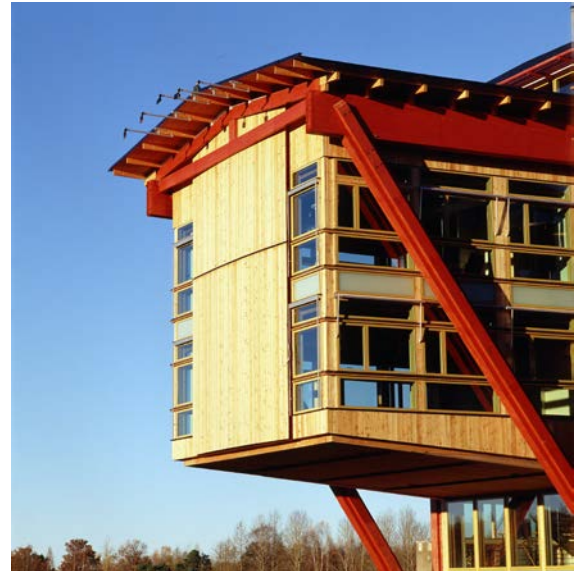
Kontorshus med stomme av pelare och balkar av limträ. Samverkansbjälklag av limträ och betong. Kv. Uppfinnaren, Växjö.
