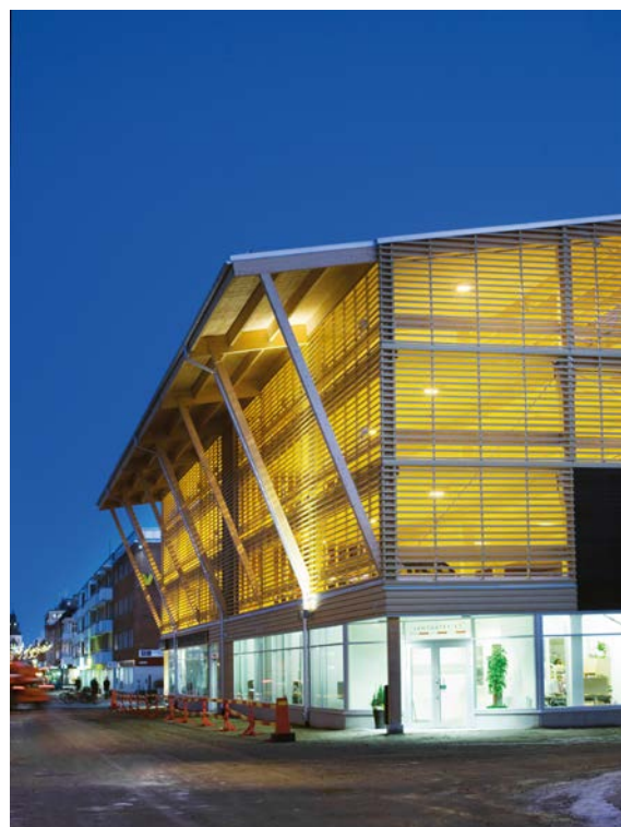
Figur 94 Limträbalkars yta kan vara upp till 20 procent av golvarean utan krav på behandling för att uppnå högre ytskiktssklass än europeisk klass D.
