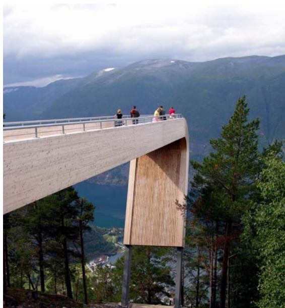
Utsiktsbro av limträ i Stegastein, vid Aurlandsvegen, Norge.
