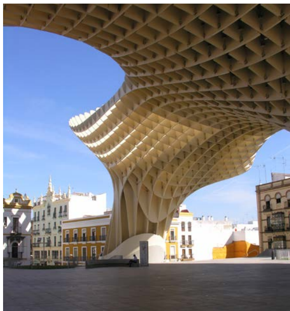
Metropol Parasol i Sevilla med skyddande ytskikt av polyuretan.
